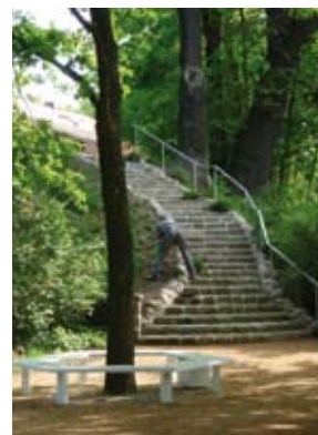
sanierte Treppe am Wall mit Rundbank um die Eiche
